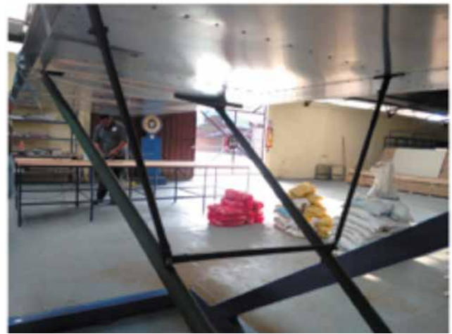
Figura 24. Instalación de Jury Struts
